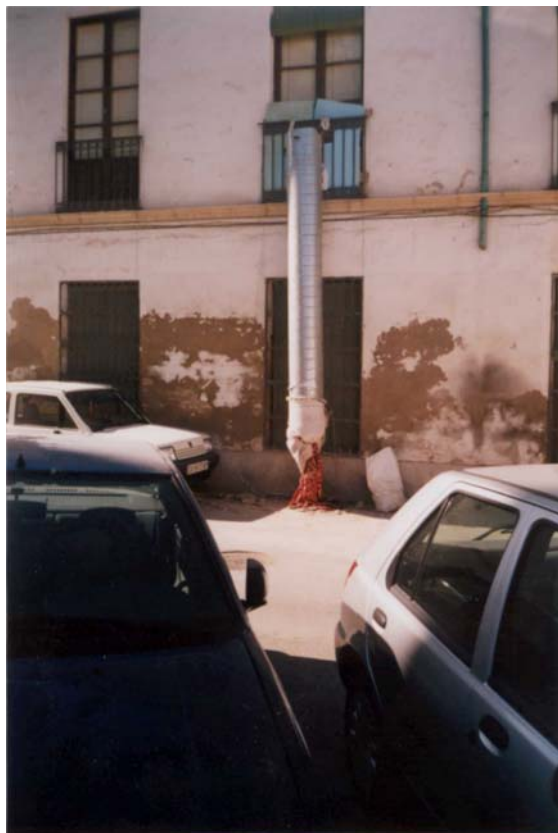
Ilustración 1. Calle estrecha, sin acerado, con pavimento en mal estado en Axarquía (San Francisco).
